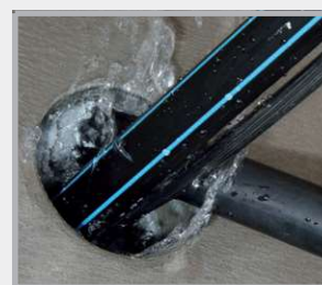
Nastříkejte hmotu Flex 2000
