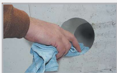
Odstraňte z jádrového otvoru prach
