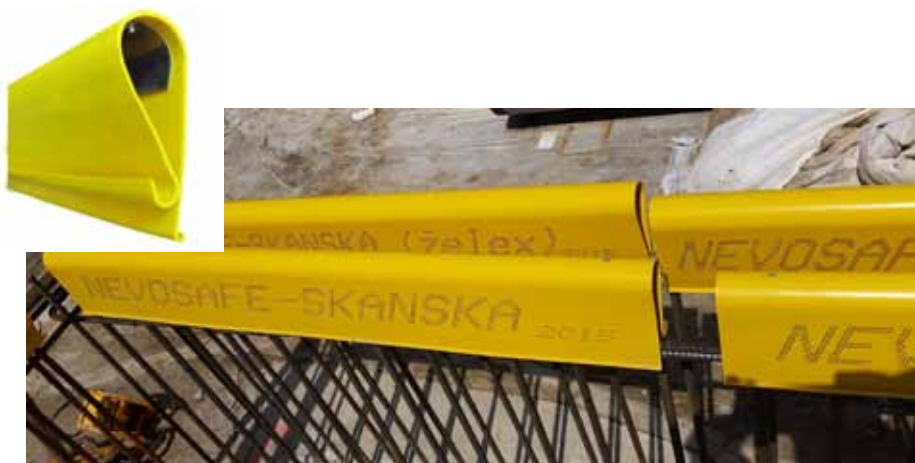
SPS profil na řadě stojící armatury
