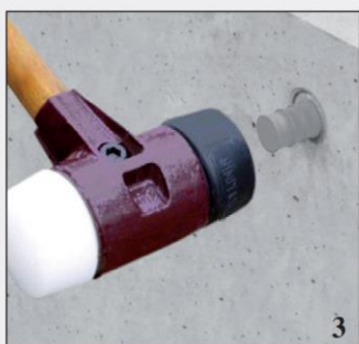
3 Zatlukte STOPPER gumovým kladivem
