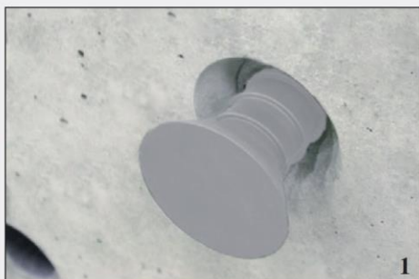
1 Uzavření kuželového otvoru
